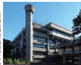
写真 世田谷区役所第一庁舎
